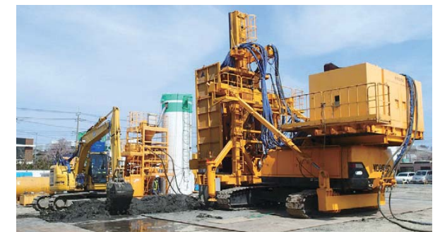
原位置封じ込め(エコウォール工法)
