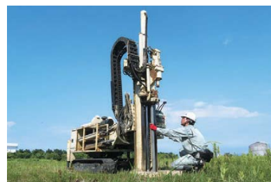
充実した設備によるボーリング調査
